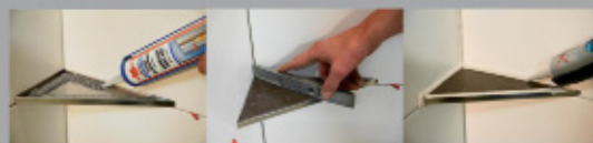
Fliese oder Glas mit Neutralsilikon bzw. Spezialkleber anbringen
