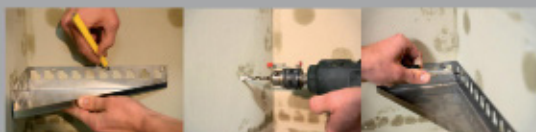
Bohrmarkierungen anzeichnen
